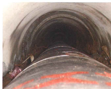
拡芯スズタイプ:施工完了後モルタル充填前
