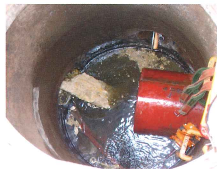
マンホール1号到達
