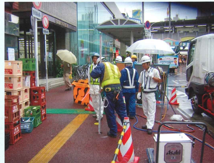
ガス管の沈下量を測る沈下絵の設置
