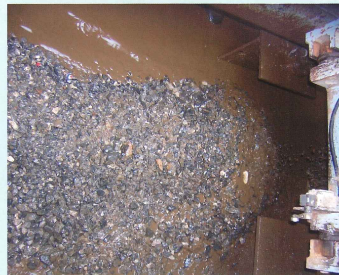
切削中の切削ズリ及び鉄筋状況
