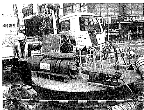
写真-9 先導管とカッターガイド
