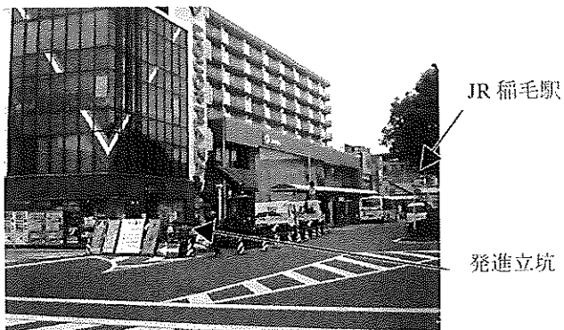
写真-7 稲毛駅前工事場所全景
